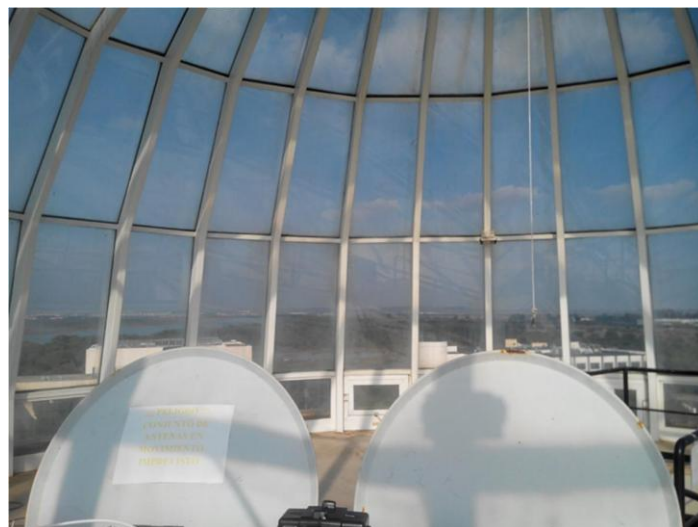
Figura 8.27. Vista de cúpula del CASEM.
