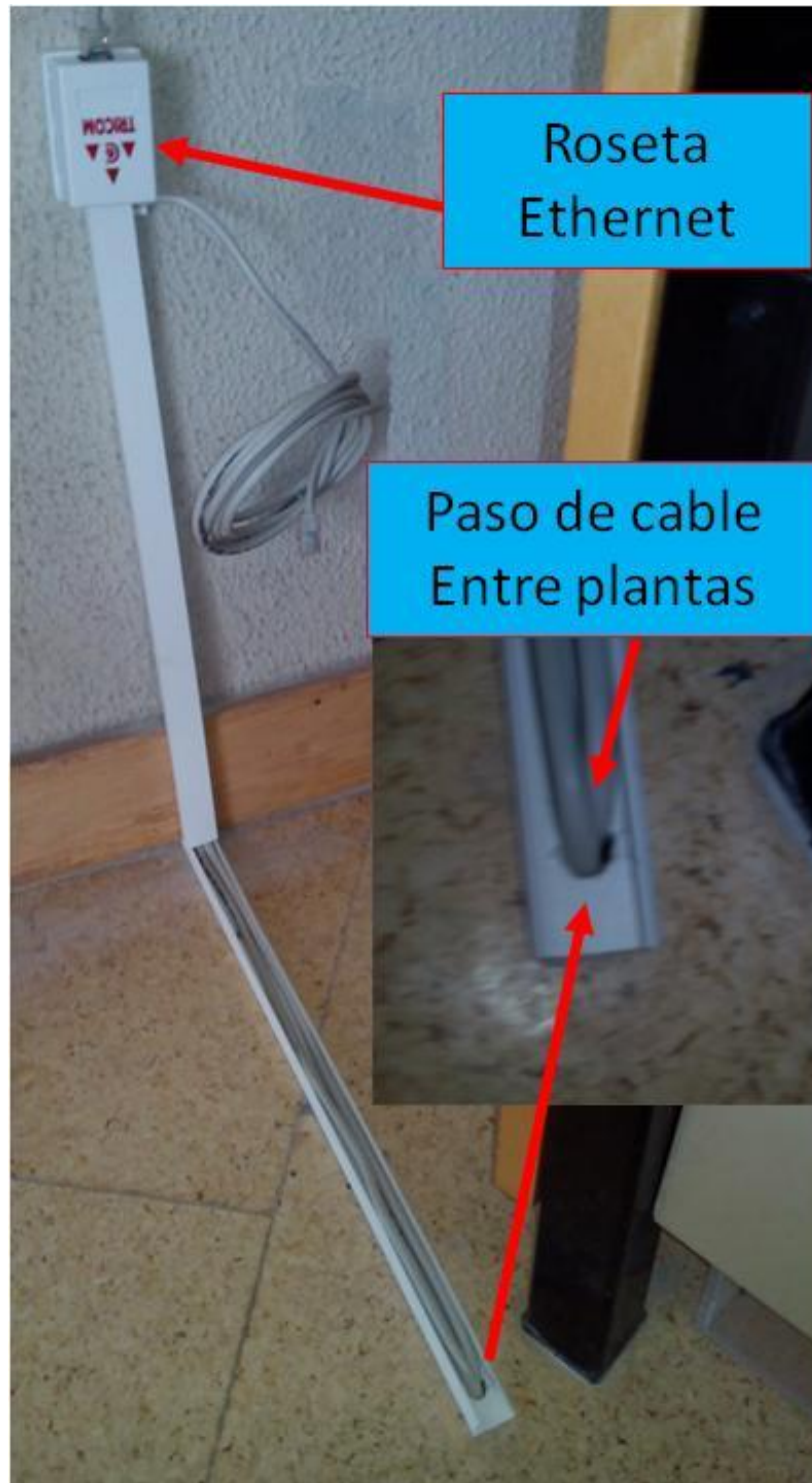
Figura 8.51. Acometida cable UTP planta superior (tapa de canaleta retirada para la imagen).
