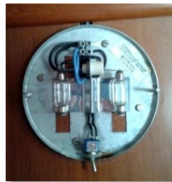
Luminaria existente a bordo en cabinas y aseos, con lámparas incandescentes (centro) y con led canbus (derecha)
